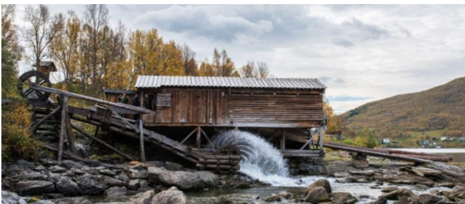
Aursfjordsaga – den eneste bevarte oppgangssaga i Nord-Norge Den ble revet i 1958 fordi det ble bygd ny vei like forbi sagbruket. Men folk med blick for historie tok vare på både sagramme og annet utstyr, og saga ble i tiden 1977 – 1982 restaurert.
