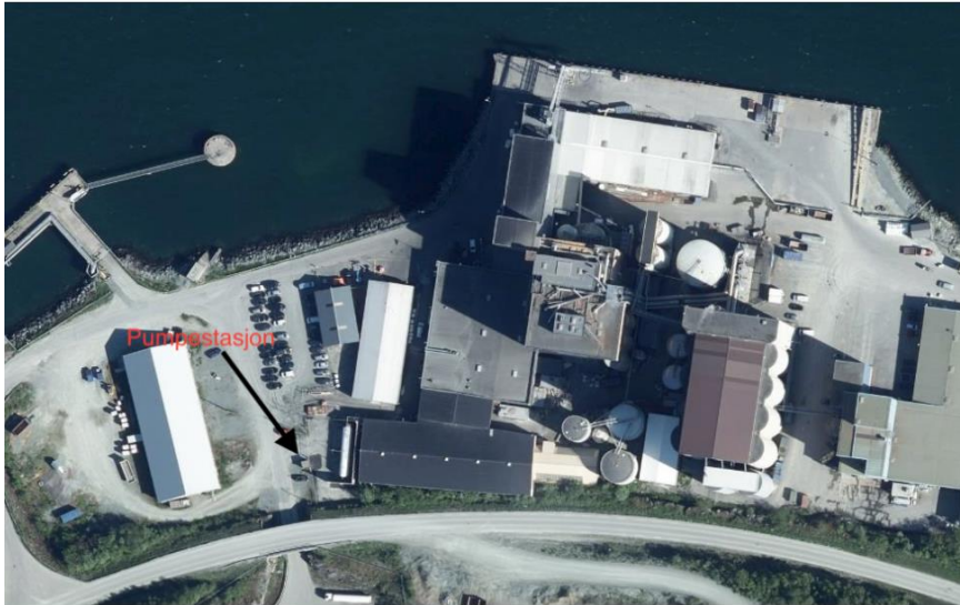
Figur 4-16 Oversikt over Bergneset med en kommunal pumpstasjon. Bildet er hentet fra Gemini-VA. Det er ikke registrert spillvannsledninger på Bergneset i Gemini-VA
