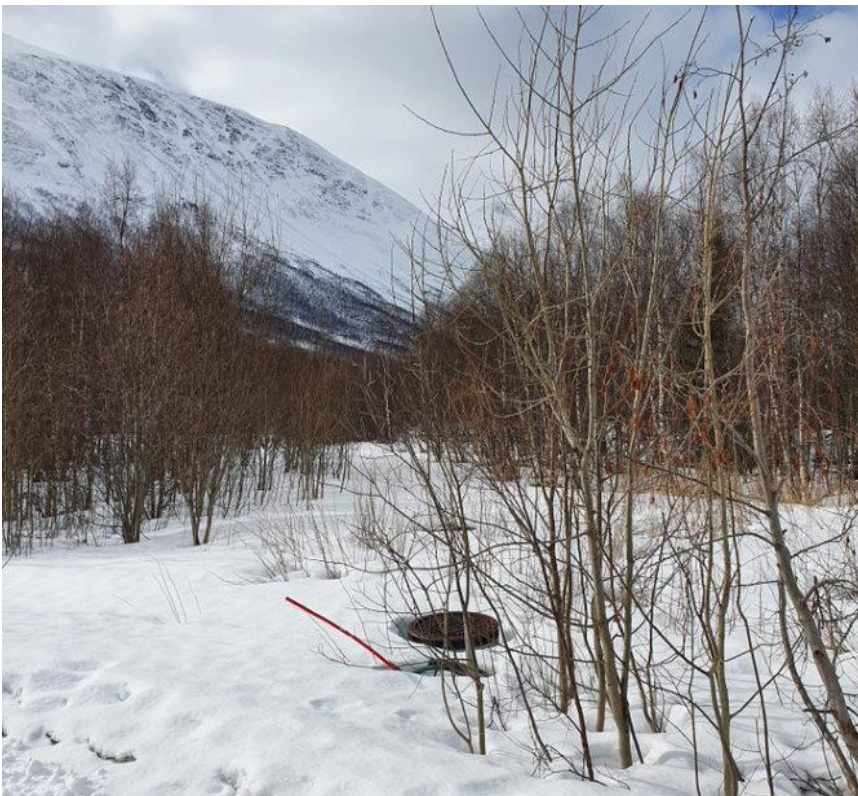
Figur 4-14 Lokalitet for slamavskiller og infiltrasjonsgrøfter på Steinvollan. Foto fra befarings.
