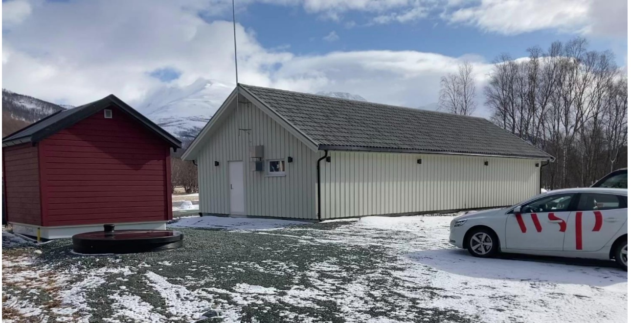
Figur 4-6 Nytt reanseanlegg på Sjøvollan Nordkjosbotn. Bilde tatt på befaring.
