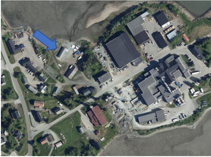
Figur 4-23 Flyfoto som viser beliggenheten til renseanlegget på Storsteinnes.
