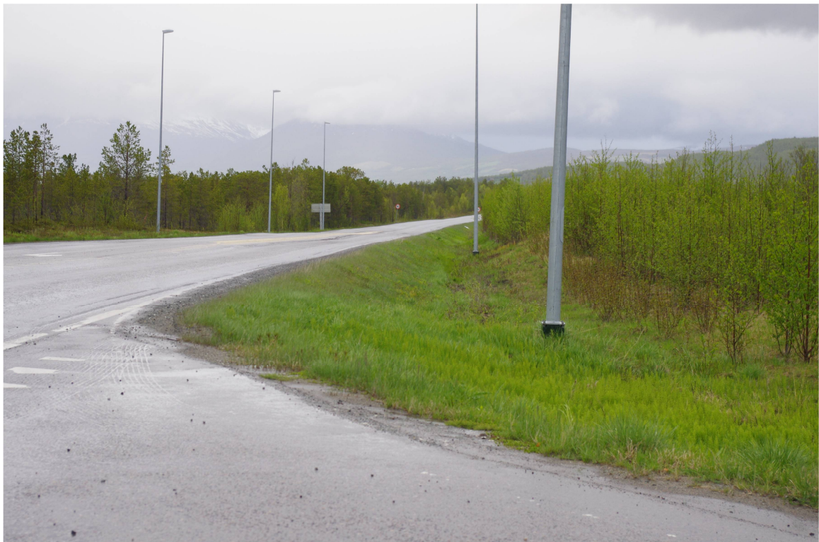
Vollen sett fra krysset mellom kommunal veg og E6.
