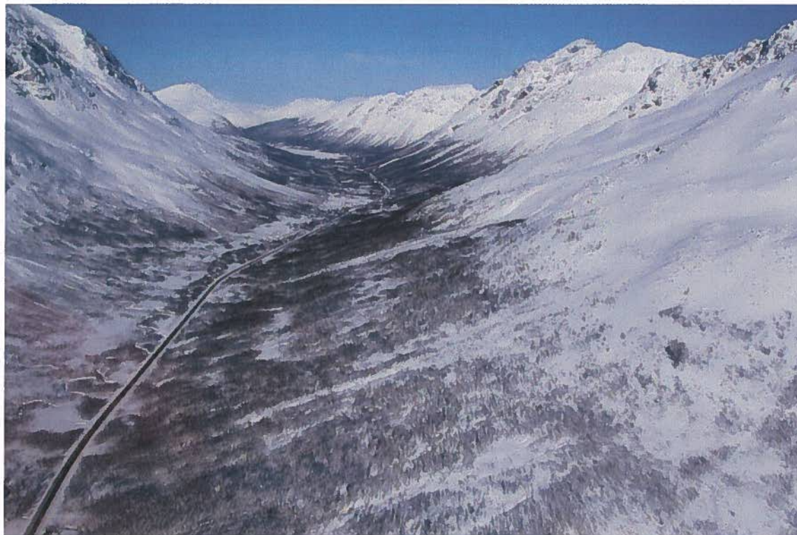
Figur 4: Lavangsdalen mot nord (foto: Statens vegvesen, 2011)
