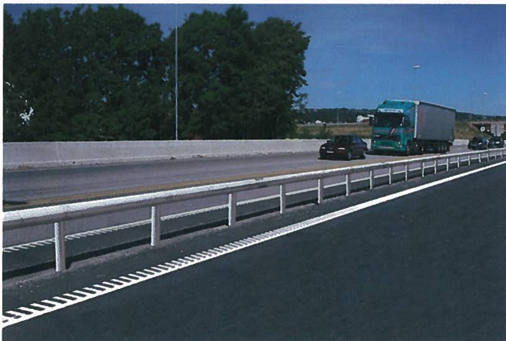
Figur 14: Eksempel på smalt midtrekkverk
