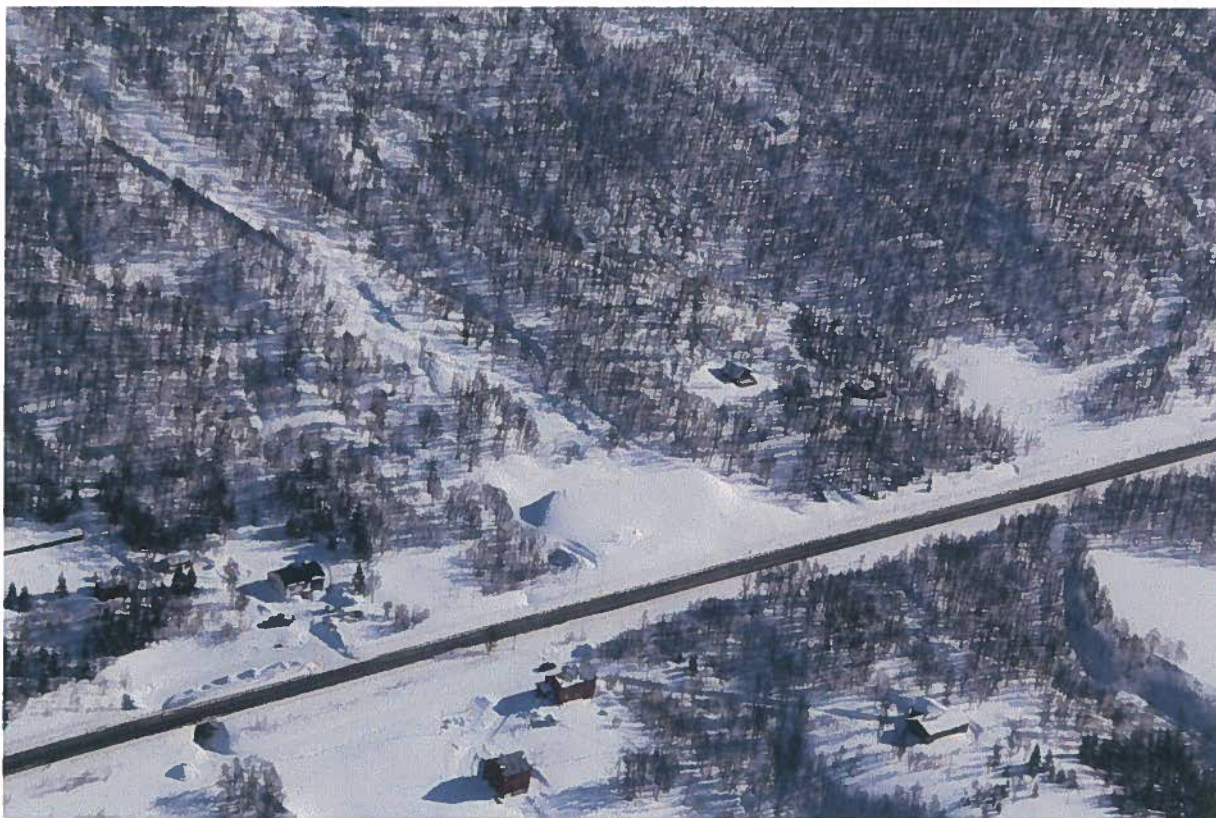
Figur 7 Eksisterende skredvoll på Skavskogen, Tromsø kommune (foto: Statens vegvesen, 2011)
