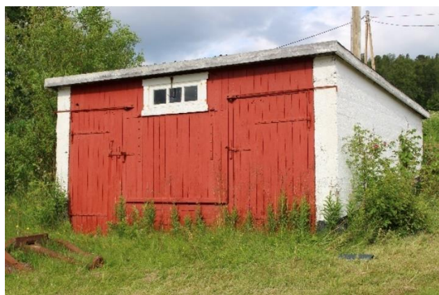
VINSJHUSET, HOLMENES SLIPP OG BÅTVERKSTED. 10021-3. FOTO BK.
