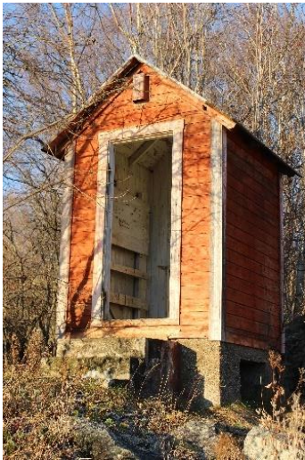
KABELHUSET PÅ YTRE TENNES. FOTO BK.
