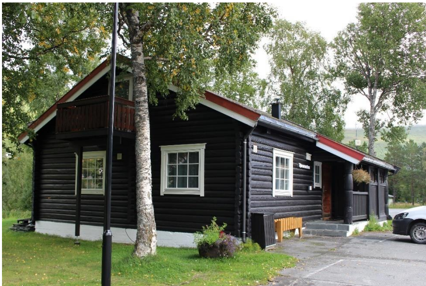
BLOKKHUSET. 10035-2. FOTO BK.
