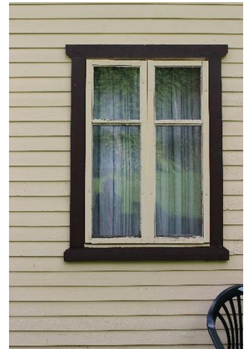
OPPRINNELIG HADDE BOLIGHUSET SEINEMPIREVINDUER.
