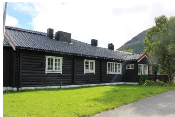
VOLLAN GJESTESTUE. OPPRINNELIG INNGANG FRA VEIEN, MOT FJORDEN. 10035. FOTO BK.
