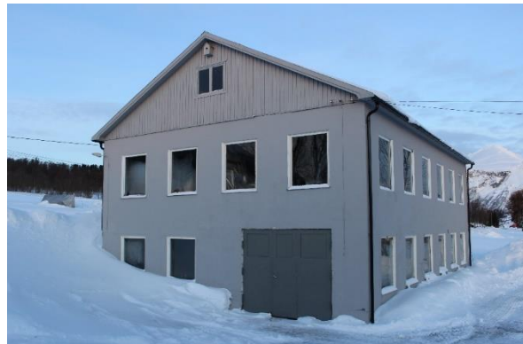
PLASTBÅTVERKSTEDET. 10007-2. FOTO BK
