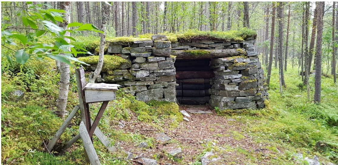
KONGBUNKERSEN. 10085-4. FOTO BK.
