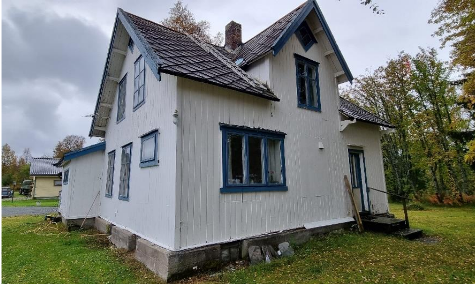
VÅNINGSHUSET, GRØNNVOLL. 10114-1. FOTO BK.
