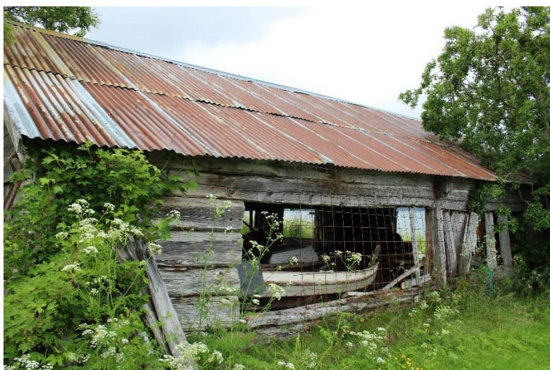
SKJELTERNAUSTET PÅ KARLSRUD I 2020, FØR I STANDSETTING. 10012. FOTO BK.
