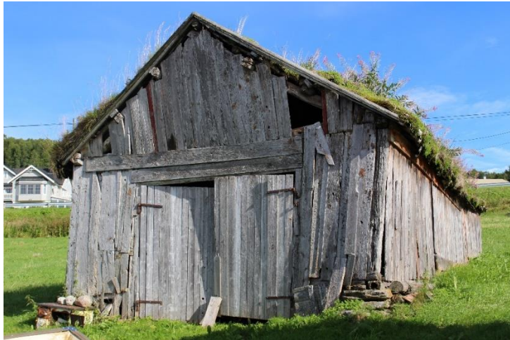
NAUST 1, NAUSTREKKE SELJELVNES. 10032-1. FOTO BK.
