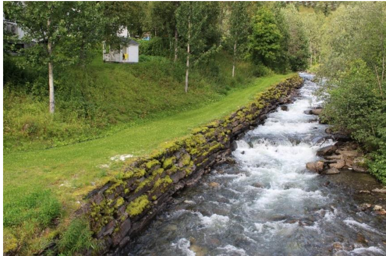
FORBYGNING BOMSTADELVA. FOTO BK.
