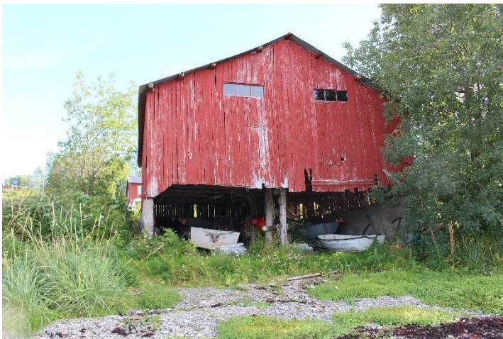
NAUST 3, NAUSTREKKE SELJELVNES. 10032-3. FOTO BK.
