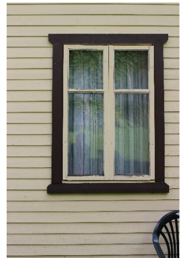
OPPRINNELIG HADDE BOLIGHUSET SEINEMPIREVINDUER.
