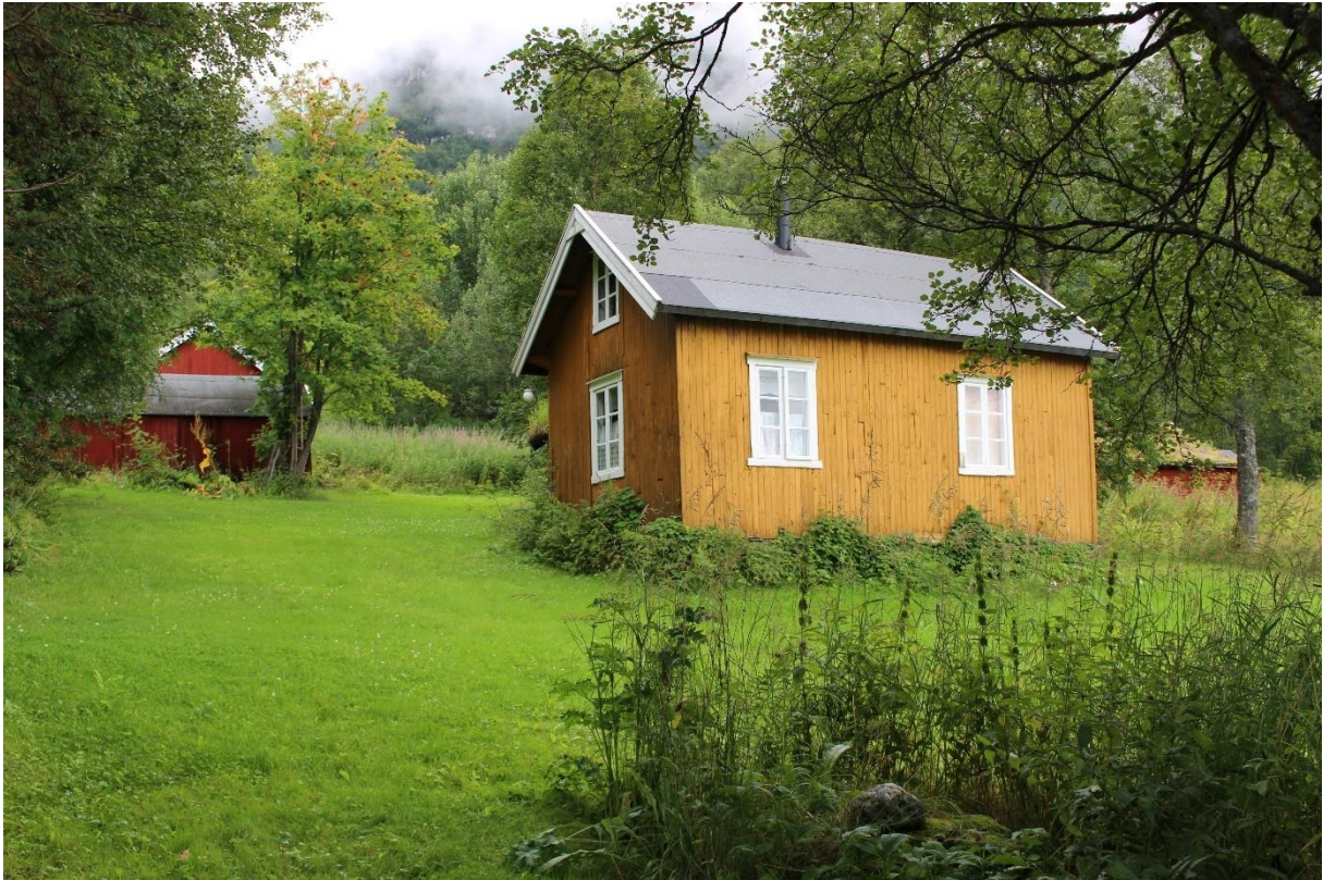
ELVEBAKKEN GÅRD, STUA/VÅNINGSHUSET. 10028-1. FOTO BK.
