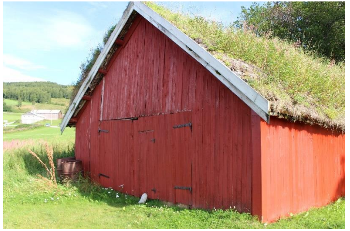
NAUST 4, NAUSTREKKE SELJELVNES. 10032-4. FOTO BK.
