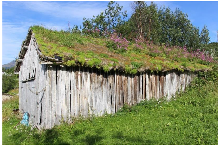
NAUST 2, NAUSTREKKE SELJELVNES. 10032-2. FOTO BK.
