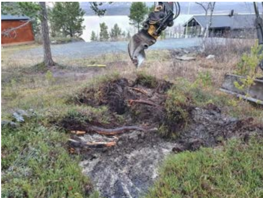
Figur 17: Prøvegropa PG.3, hus i nr. 3 til høyre, vist mot sør (Bilde tatt av Norconsult, 2021-11-02).
