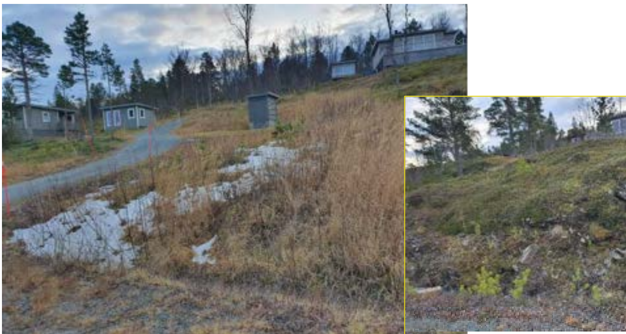
Figur 12: Tømmervikbakken nr. 34 til venstre og nr. 36 til høyre, vist mot sør og berg i dagen nedenfor nr. 34 (Bilde tatt av Norconsult, 2021-11-02).
