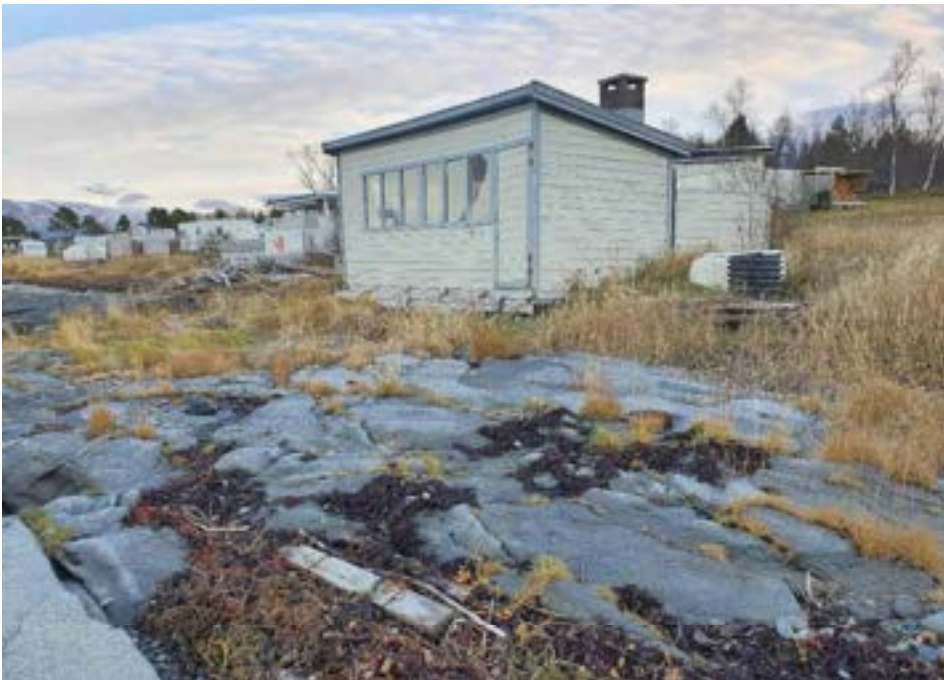
Figur 6: Stranda ved kanten av tomta, østlige del (Bilde tatt av Norconsult, 2021-11-02).
