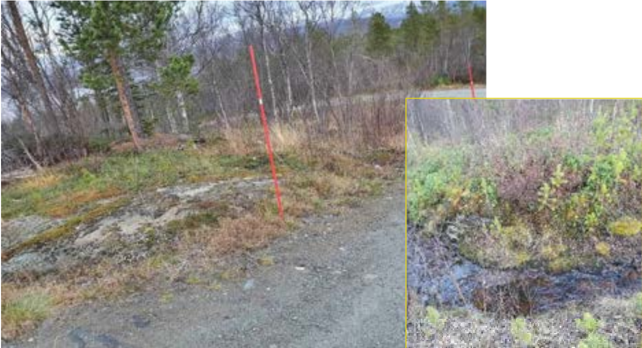
Figur 13: Bergbløtning og grøft øst for Tømmervikbakken nr. 29 (Bilde tatt av Norconsult, 2021-11-02).
